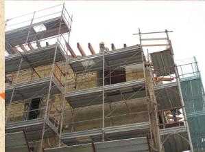
Fasi montaggio in sicurezza
