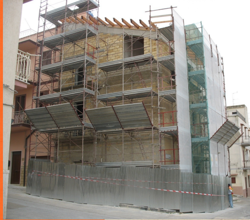
Fase di allestimento
