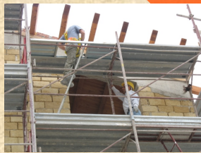
Procedura di lavoro in sicurezza con sistema di arresto caduta con dispositivo retrattile.
