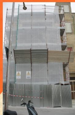
Fase di allestimento
